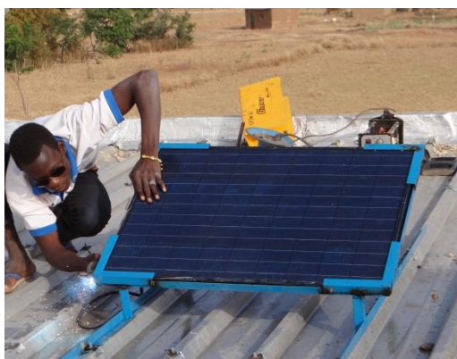
Das PV-Modul wird gegen Diebstahl gesichert
